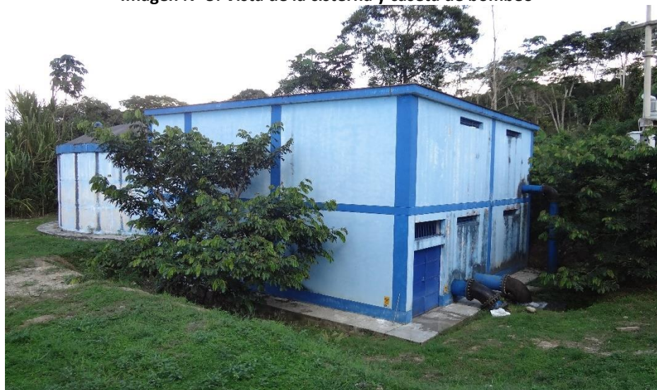
Imagen N° 5: Vista de la cisterna y caseta de bombeo
