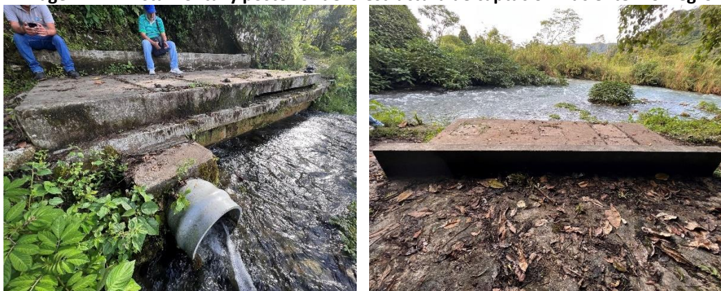
Imagen N° 4: Vista frontal y posterior de la estructura de captación Naciente Río Negro
