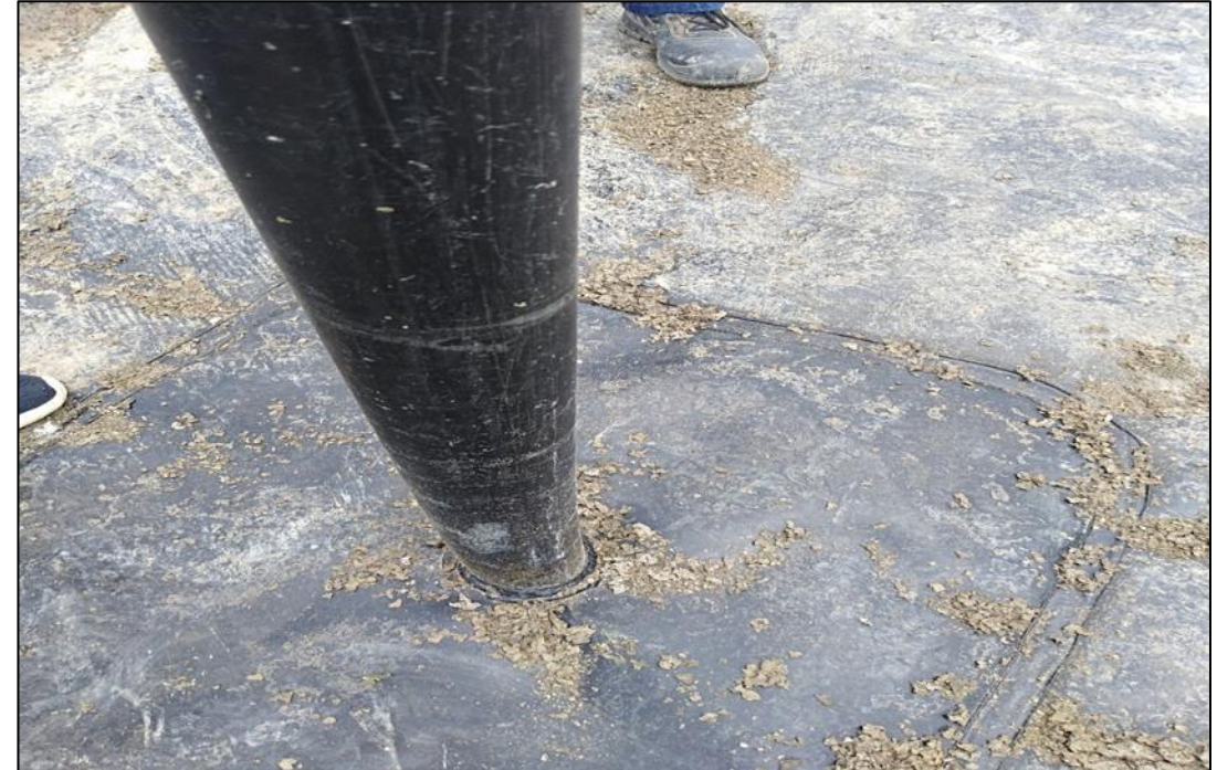
INSTALACION DE AEREADORES EN PUNTOS ROTOS
