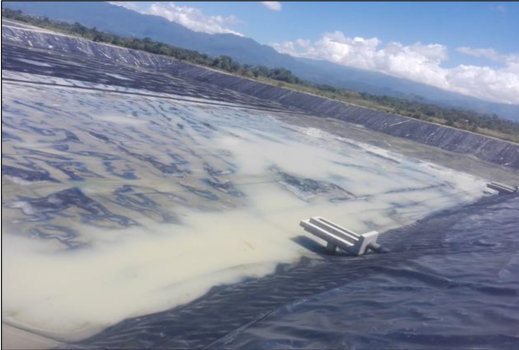
LAGUNA DE MADURACION SECADA PARA INSTALAR AEREADORES
